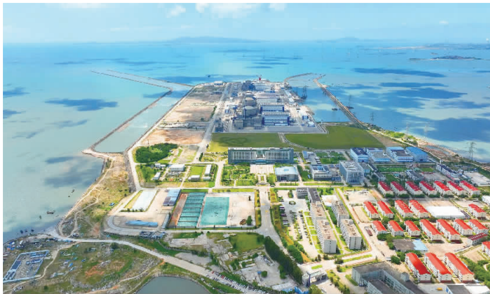
▲图为福清核电“华龙一号”示范工程。
