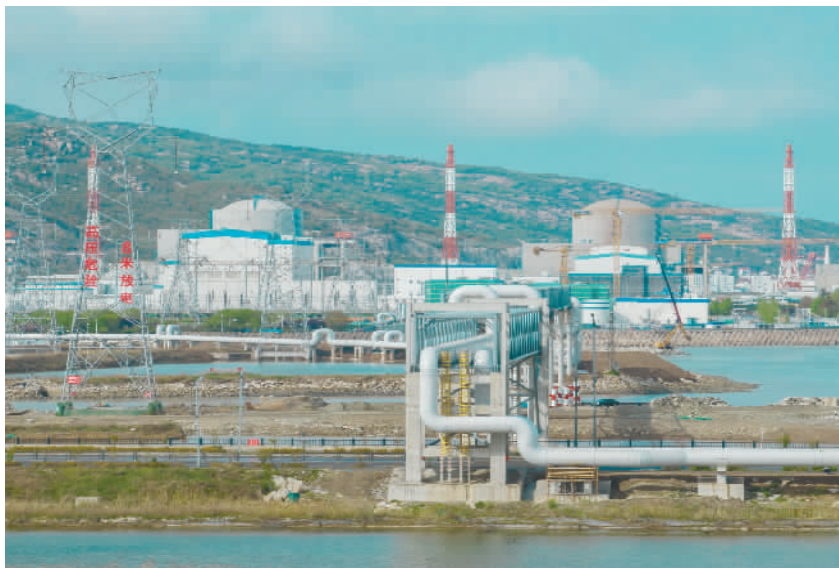
图为“和气一号”项目蒸汽供能管道。
