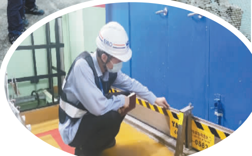
▲图为华东监督站监督员在福清核电厂柴机油厂房开展防汛防台工作检查。 潘振华摄
