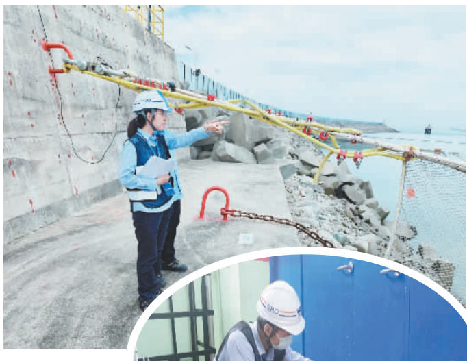
▲图为华东监督站监督员在福清核电厂取水明渠开展防汛防台工作检查。 曹坤摄
